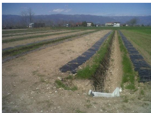
Area di ricarica di Pozzoleone
